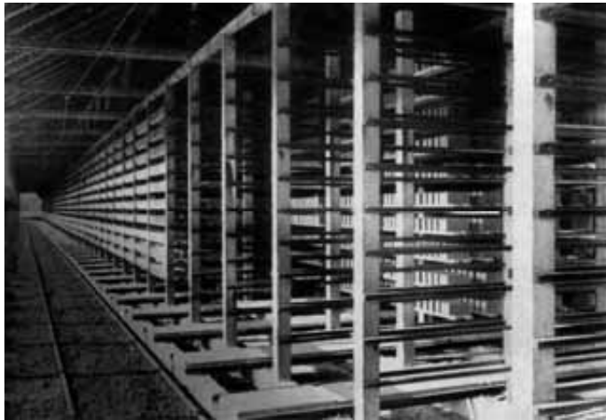
Freilufttrockenanlage für 800.000 Ziegelsteinrohlinge.
