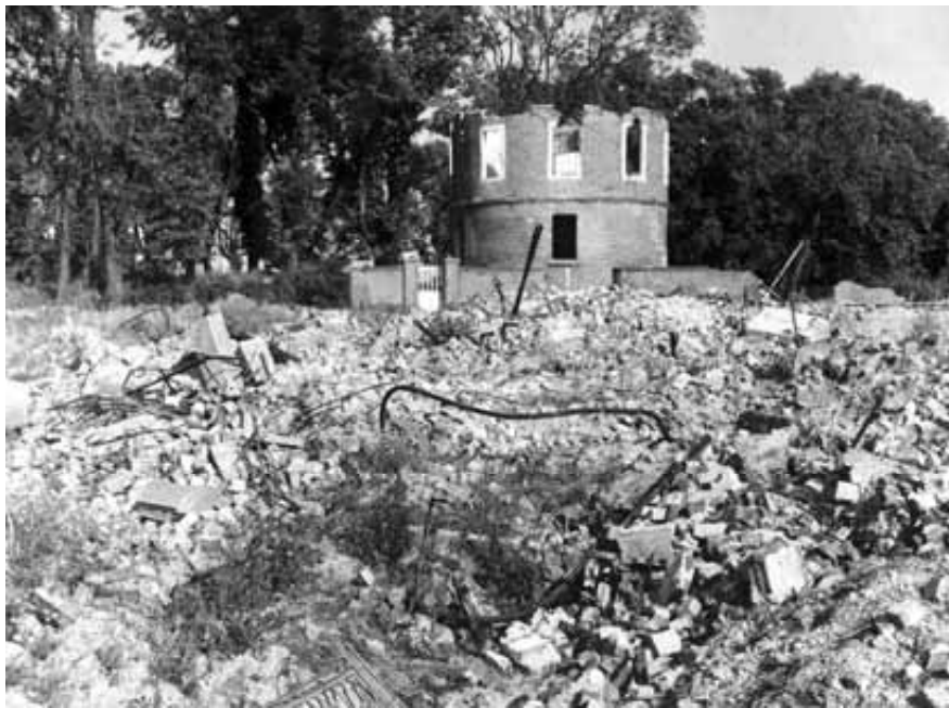
Der Pulverturm, heute Domizil des Heimatvereins, wurde beim Luftangriff auf Coesfeld am 22. März 1945 schwer beschädigt. Foto: Sammlung Borgert.
