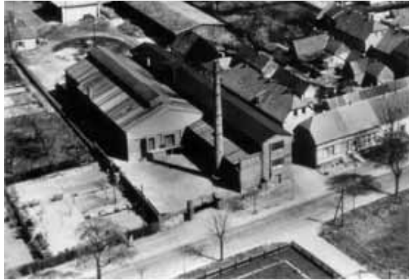
Ehemalige Seifenfabrik F. Wessendorff.
