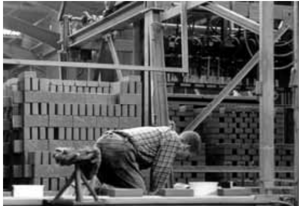
Handsetzen der Klinkersteine.
