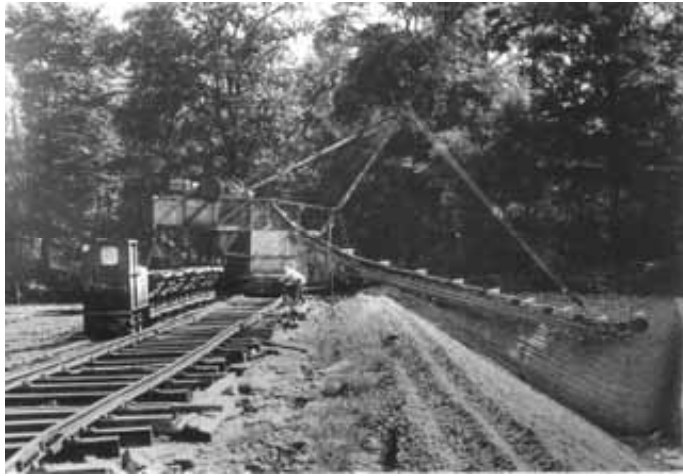
Kettenbagger für die Tonschürfung und Lorenbahn.
