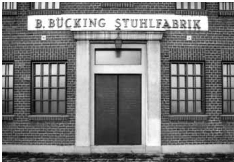
Ehemaliger Büroeingang der Firma B. Bücking an der Dülmener Straße, 1992.
