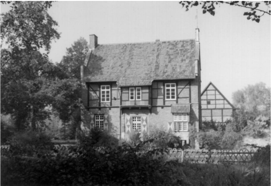
Haus Bisping in Rinkerode, Torhaus.
